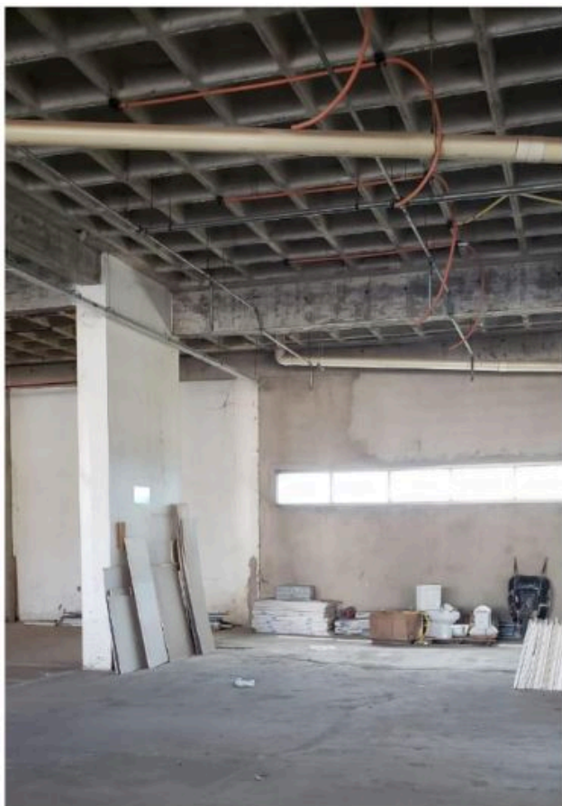
Imagem 14: Pavimento térreo, vista para os fundos do ambiente. O espaço ainda não possui instalação de pisos e forro.
