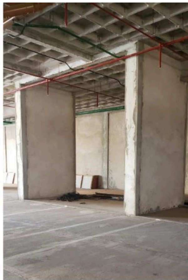
Imagem 15: Pavimento térreo, vista parcial lateral esquerda do ambiente. O espaço ainda não possui instalação de pisos e forro.
